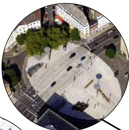
Pladdannelse i belægningen
